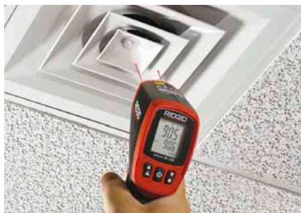
Измерение эффективности рассеивания тепла для выявления и обнаружения мест потерь тепла в системе воздуховодов
